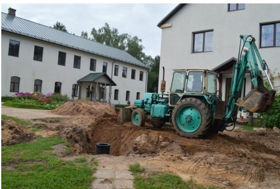
Ūdensvada un kanalizācijas renovācija. 2015.g.
